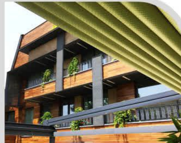
پروژه سقف متحرک پارچه ای حیاط منزل مسکونی / آجودانیه
